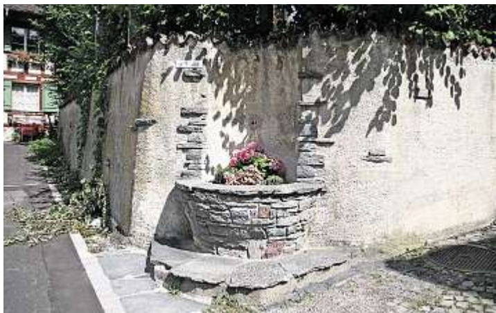
Kein Wasserspender mehr, doch im Sommer hübsch geschmückt: Ein privater Brunnen in der Müsegg, aus Granitblöcken und Zement gemauert.
